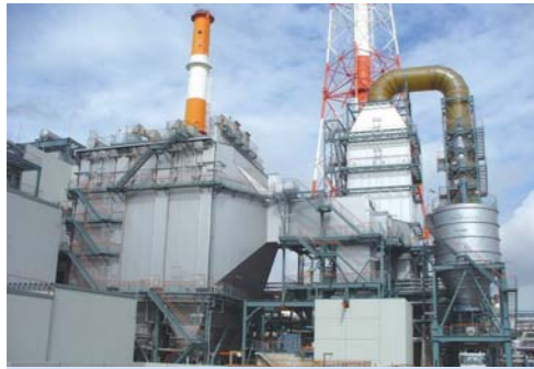
排煙脱硫装置(石灰スラリー吸収法)概念図
