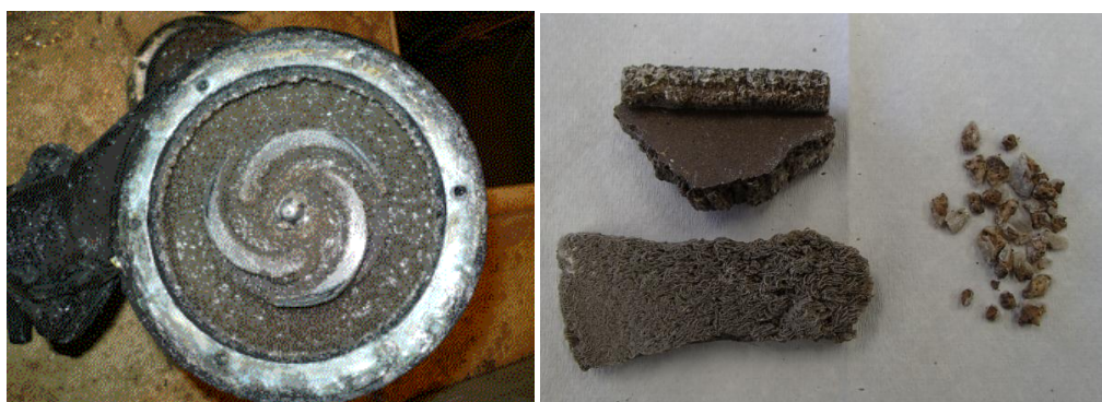
移送ポンプ内に付着した結晶化物 浄化処理施設配管等に付着した結晶化物
