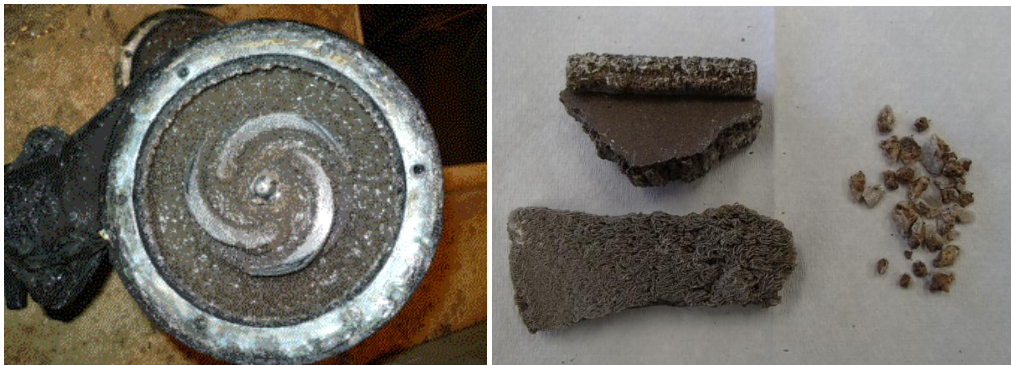
移送ポンプ内に付着した結晶化物 浄化処理施設配管等に付着した結晶化物
