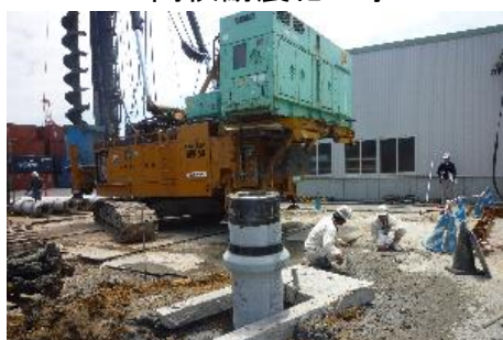
う こうじ 5 くい打ち工事
