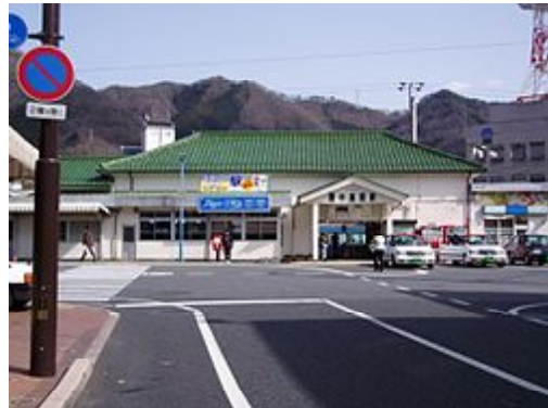
【駅舎（平成18年3月31日）】
