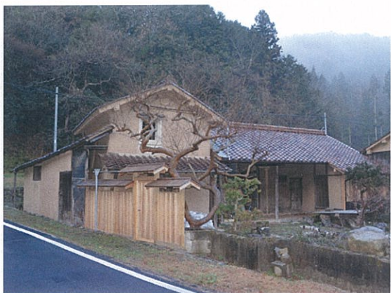
修理・修景後
