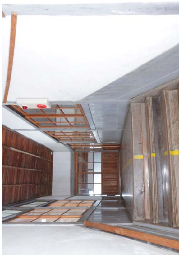
21 本館 西階段及び2階廊下
