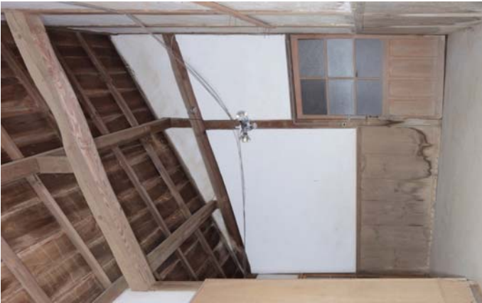
29 東校舎 北側下屋 (西より見る)
