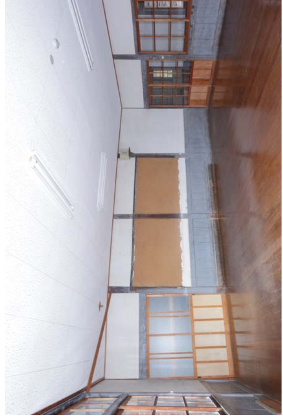
26 本館 2階教室 (東) (南東より見る)
