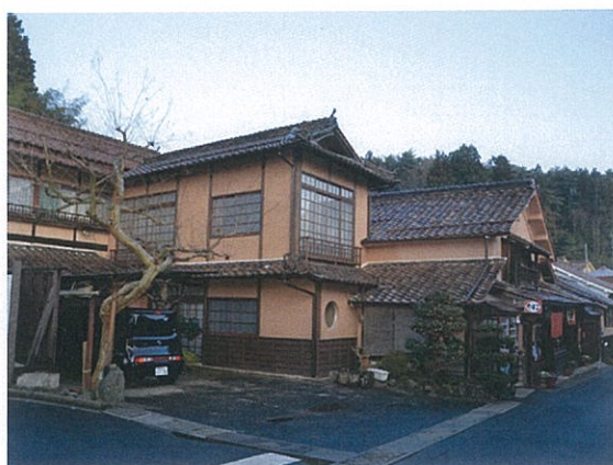
修理・修景後
