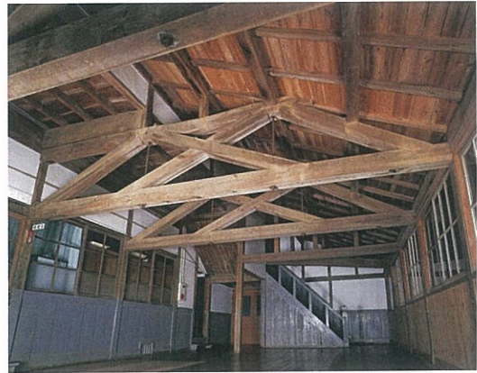
三間廊下のトラス構造
