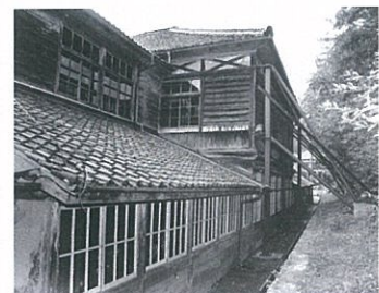
補強の状況（本館裏）
