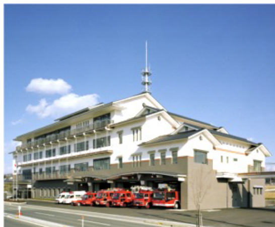
岡山県 津山圏域 消防組合 防災学習センター
