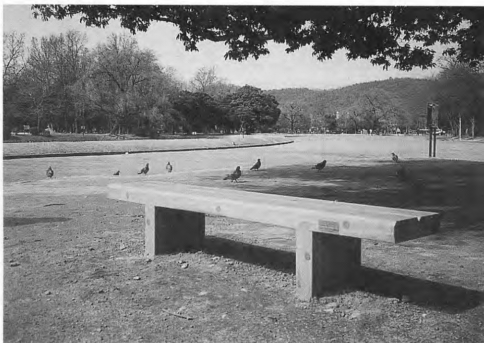
写真6 キシラデコールで塗装したベンチの設置状況
