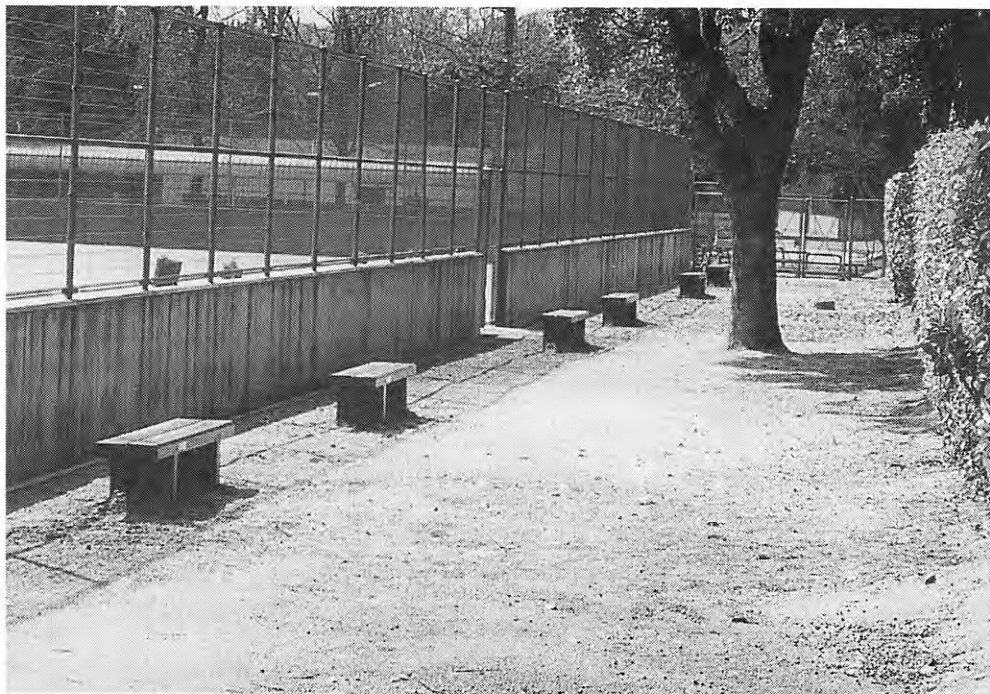
写真5 合成樹脂塗料で塗装したベンチの設置状況
