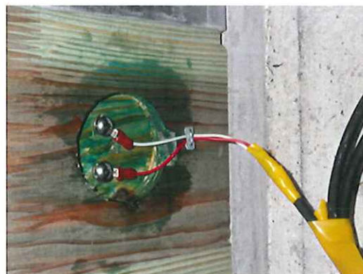
写真 2.5 基礎センサ設置状況
