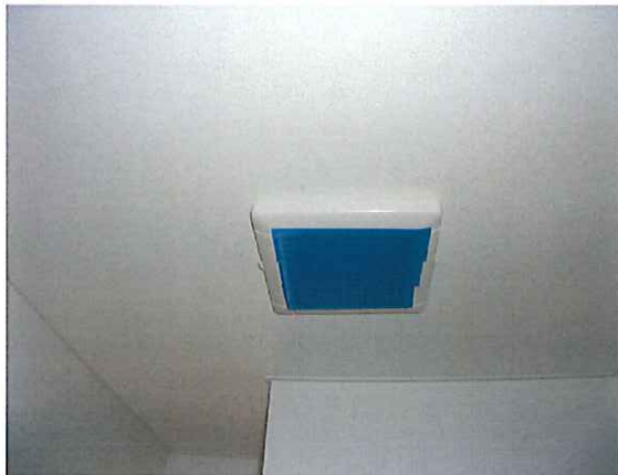
写真：03_便所 換気扇目張り状況
