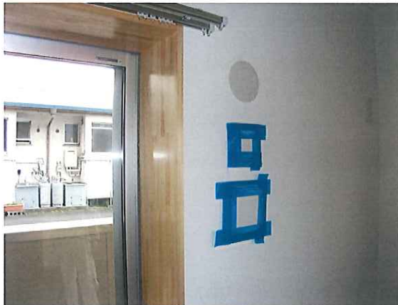
写真：02_リビング 換気レジスター目張り状況
