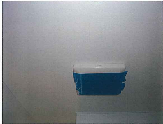
写真：03_便所 換気扇目張り状況
