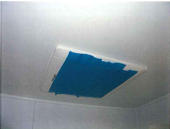
写真：04_浴室 換気扇目張り状況
