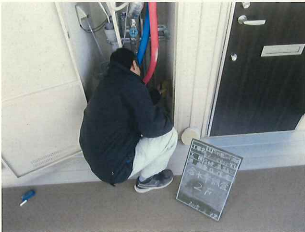
写真-20 調査状況 (3/17)
