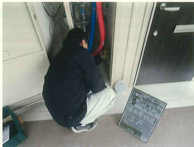
写真-25 調査状況 (3/23)
