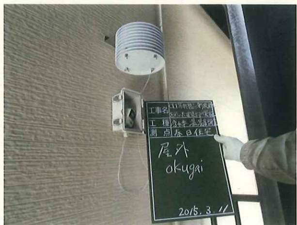
写真-5 設置状況
