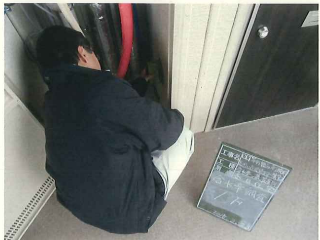
写真-17 調査状況 (3/23)
