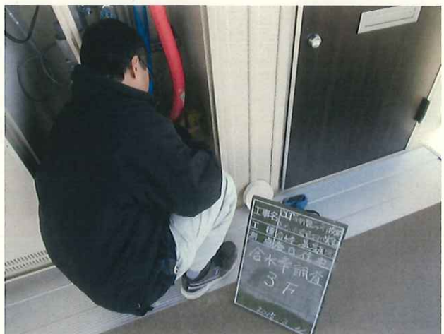
写真-23 調査状況 (3/11)
