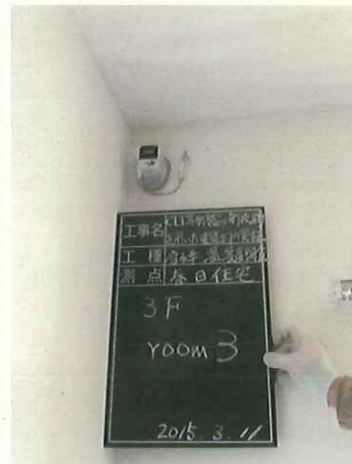
写真-11 設置状況
