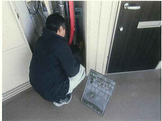
写真-15 調査状況 (3/11)
