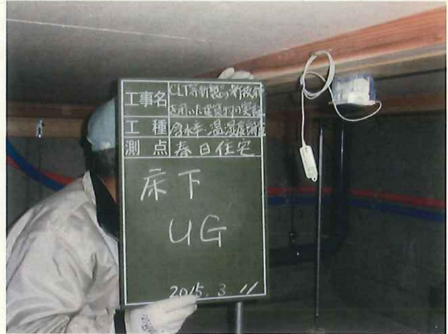
写真-13 設置状況
