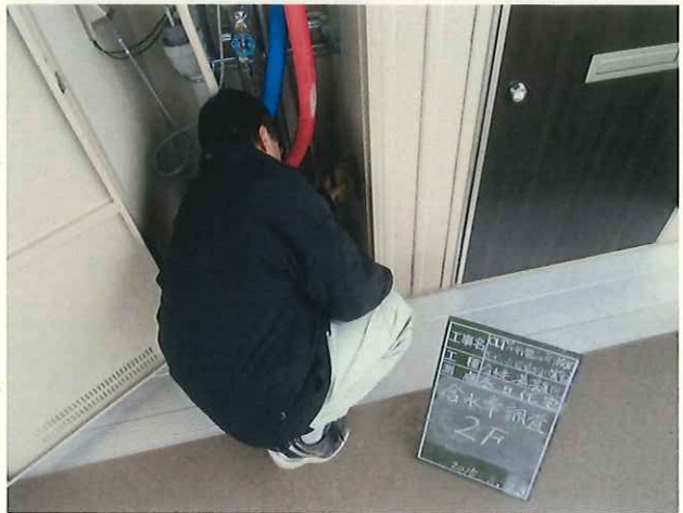
写真-21 調査状況 (3/23)
