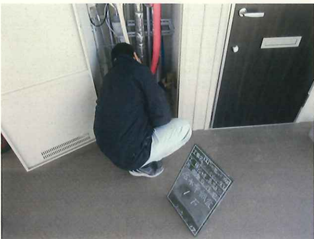
写真-16 調査状況 (3/17)
