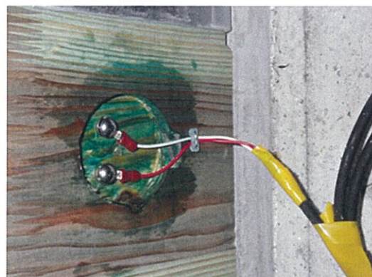
写真 2.5 基礎センサ設置状況
