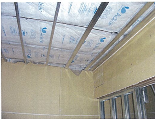
写真： O3_屋内施工状況
