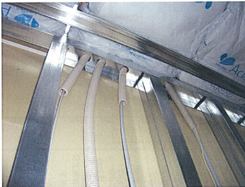
写真： O4_屋内施工状況
