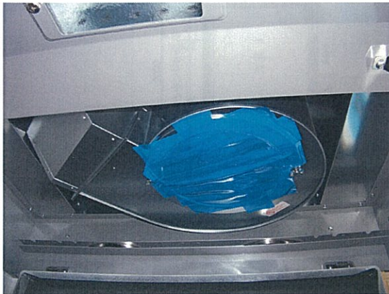
写真：04_レンジファン目張り状況
