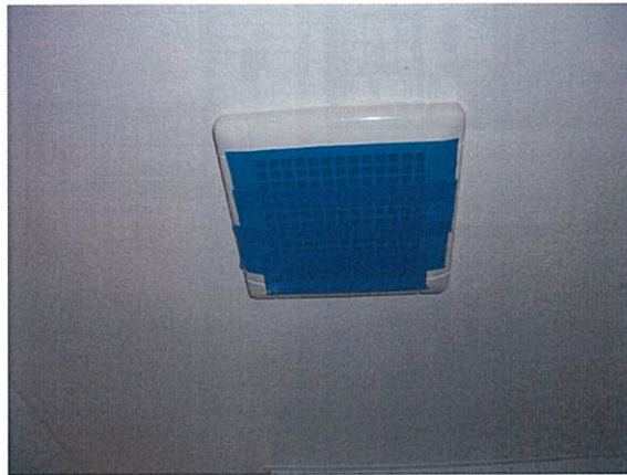
写真：O3_便所 換気扇目張り状況
