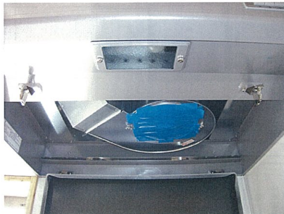
写真：O4_レンジファン目張り状況
