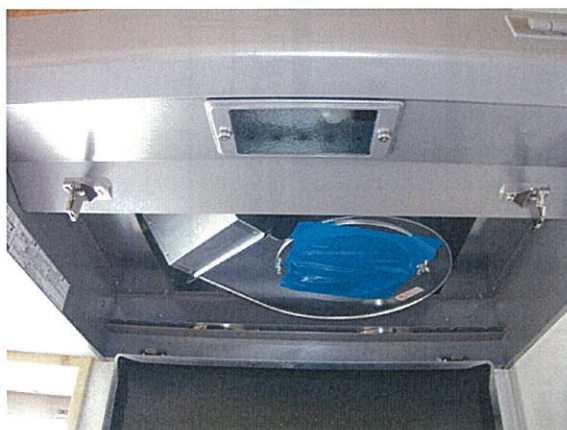
写真：04_レンジファン目張り状況
