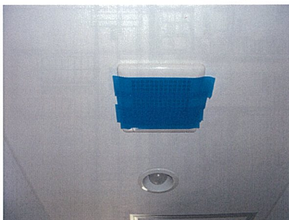
写真：03_便所 換気扇目張り状況
