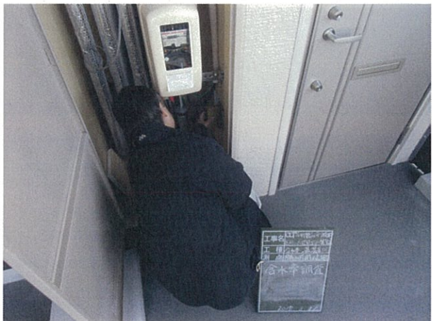
写真-30 調査状況 (3/11)
