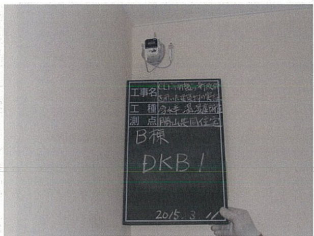
写真-16 設置状況
