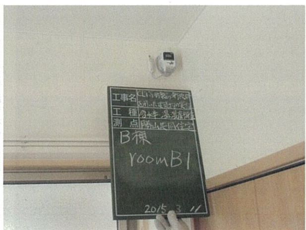
写真-18 設置状況
