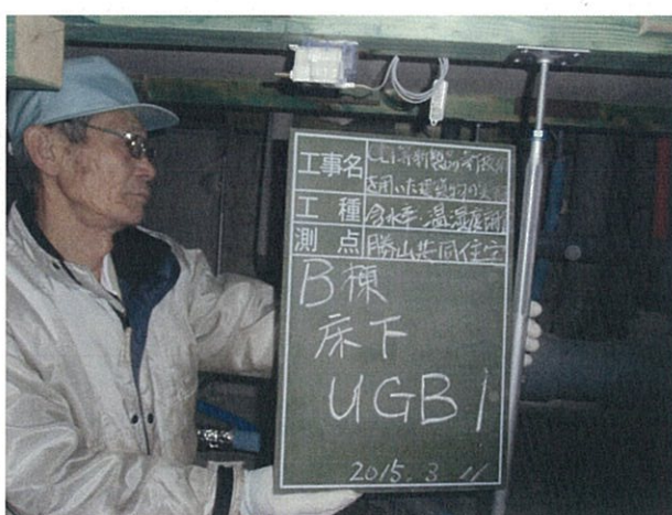
写真-24 設置状況
