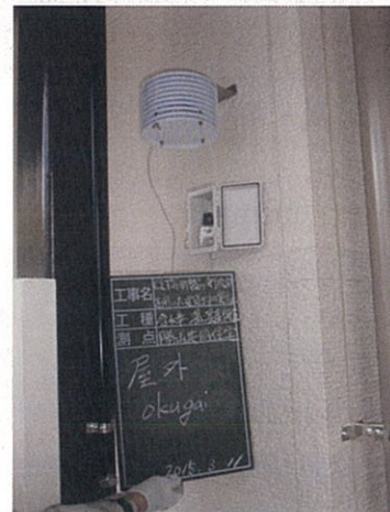
写真-5 設置状況
