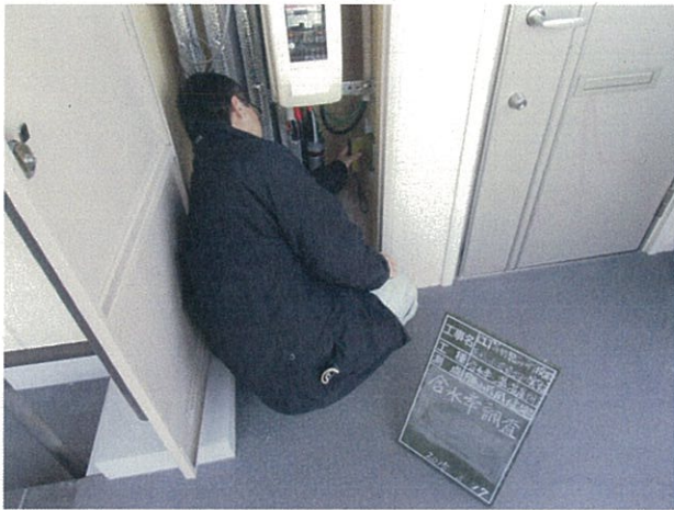
写真-31 調査状況 (3/17)
