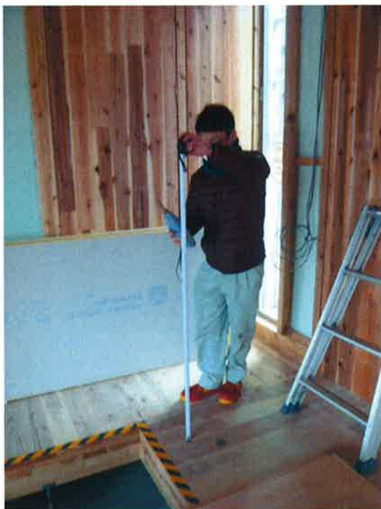
写真7 1F和室(受音側)竣工前 測定
