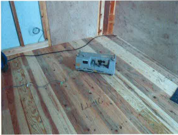
写真 1 2F 洋室(音源側)床仕上げ前 標準軽量床衝撃源(タッピングマシン)
