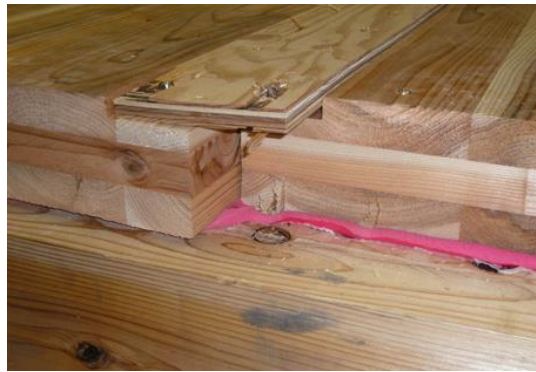
写真 3 - 2 継手の破壊状況 : 2.7HC
