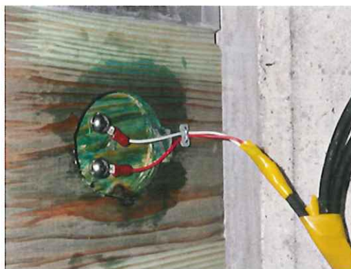
写真 2.5 基礎センサ設置状況
