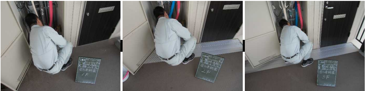
写真-12 含水率調査状況（平成28年10月13日）
