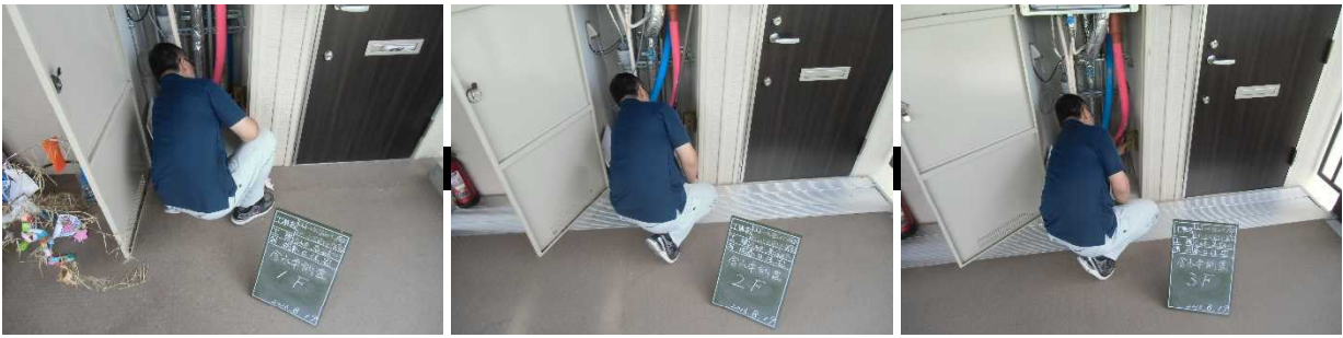
写真-10 含水率調査状況（平成28年8月19日）
