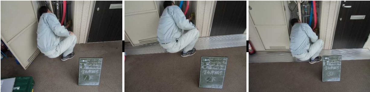
写真-19 含水率調査状況（平成29年3月15日）
