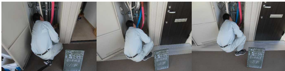
写真-5 含水率調査状況(平成28年5月13日)
