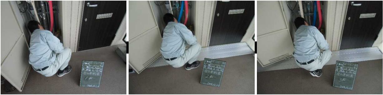
写真-15 含水率調査状況（平成28年12月22日）
