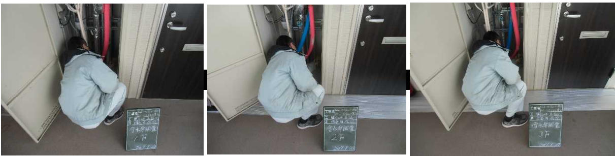
写真-17 含水率調査状況（平成29年1月27日）
