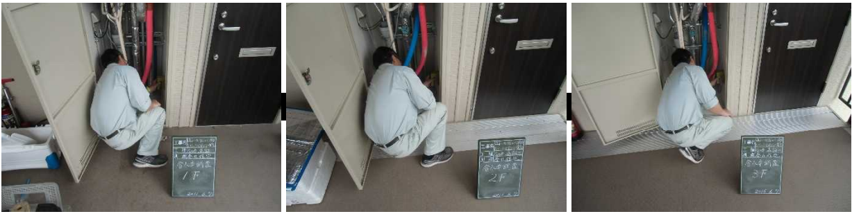
写真一六 含水率調査状況（平成28年6月7日）
