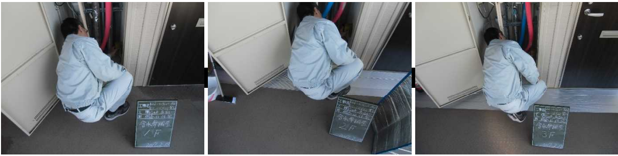
写真-18 含水率調査状況（平成29年2月15日）
