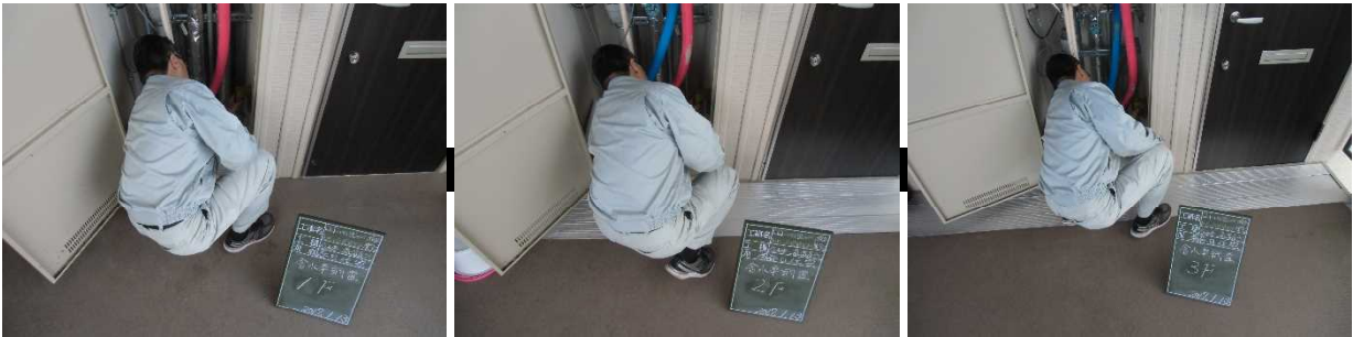
写真-16 含水率調査状況（平成29年1月13日）
