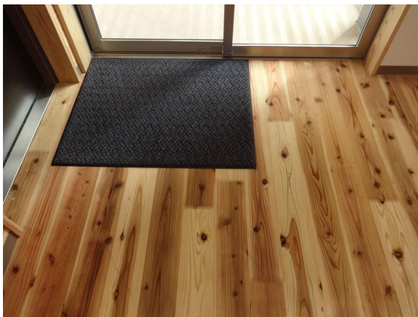
図 2-9 測定点 No.5(全景)
