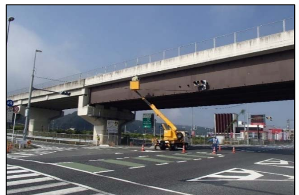
【橋梁点検の状況】
