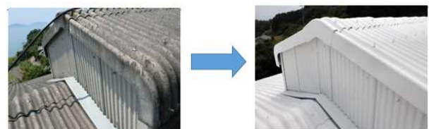
図1 施工前後の屋根写真
