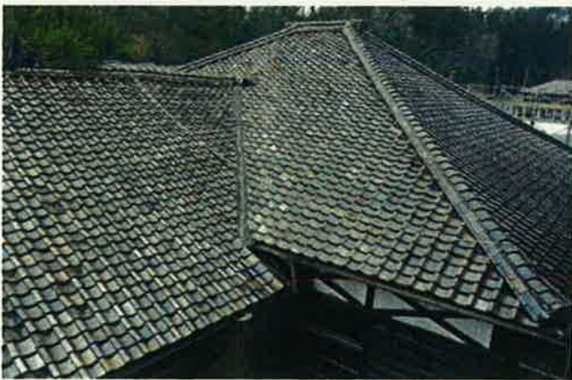
写真 2 解体前 資料館（旧本館） 屋根の状況
