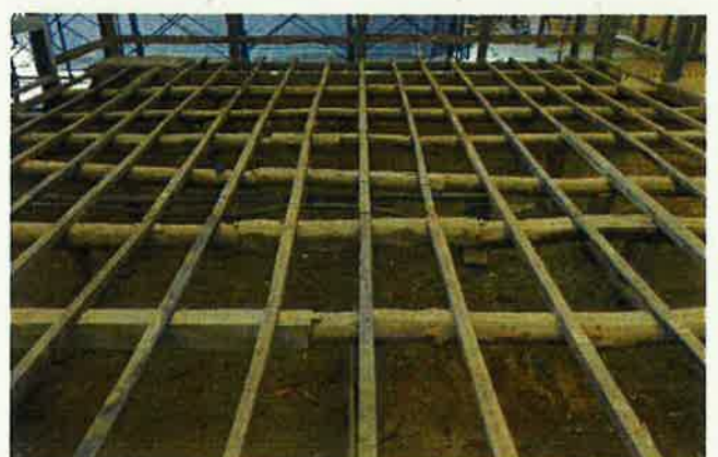
写真 13 資料館（旧本館）床組の状況（1階西教室）
