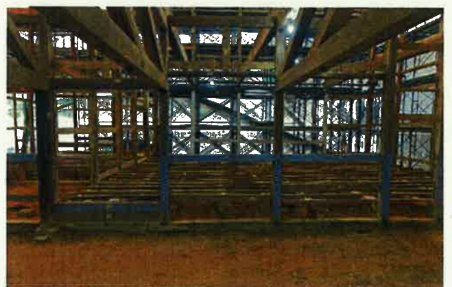
写真 11 資料館（旧本館）軸組の状況（1階西教室）
