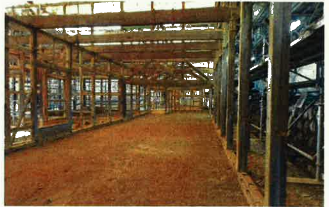
写真 15 資料館（旧本館）軸組の状況（屋内運動場）
