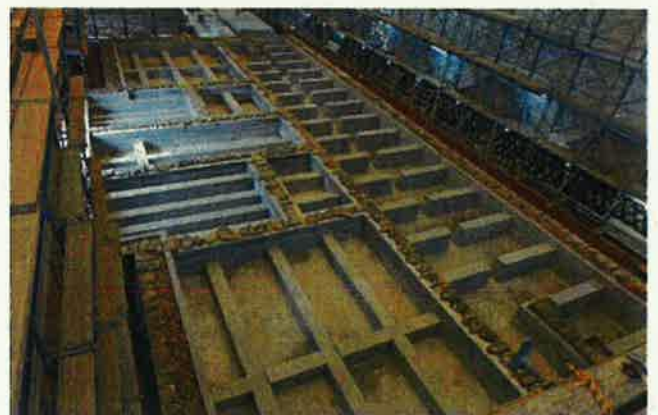
写真 19 資料館（旧本館）基礎石積み状況
