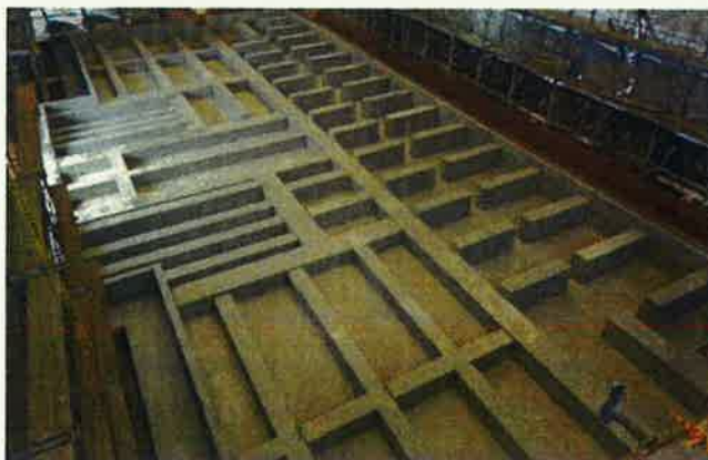
写真 18 資料館（旧本館）基礎コンクリートの状況
