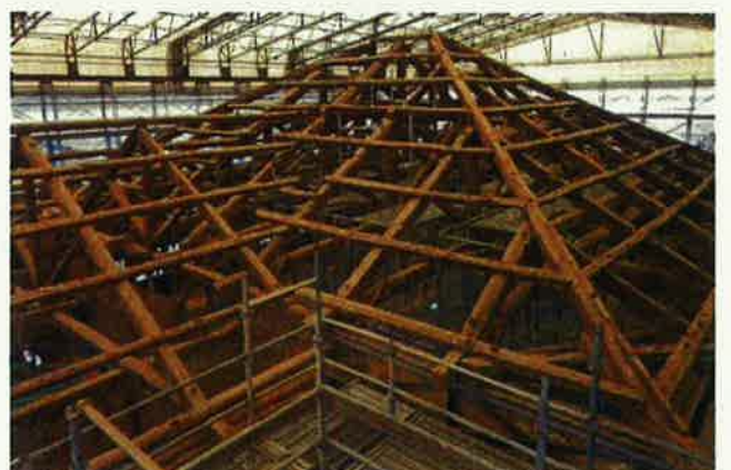
写真 5 資料館（旧本館） 小屋組の状況
