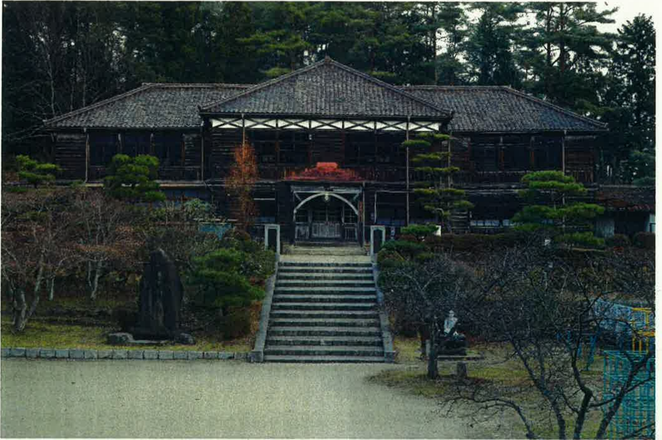
写真 1 解体前 資料館（旧本館） 正面（南面）
