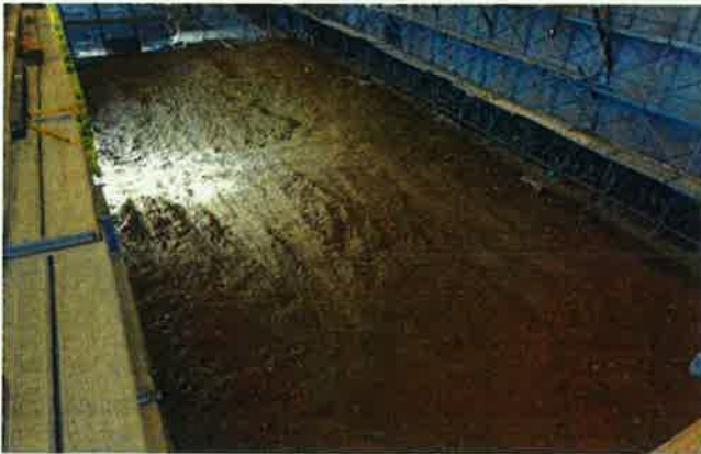
写真 16 資料館（旧本館）基礎掘削前の状況
