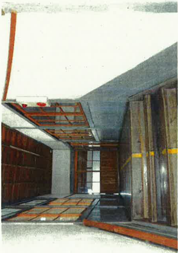
21 本館 西階段及び2階廊下
