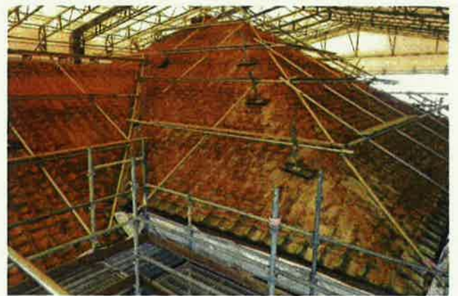
写真 3 資料館（旧本館） 葺き土の状況
