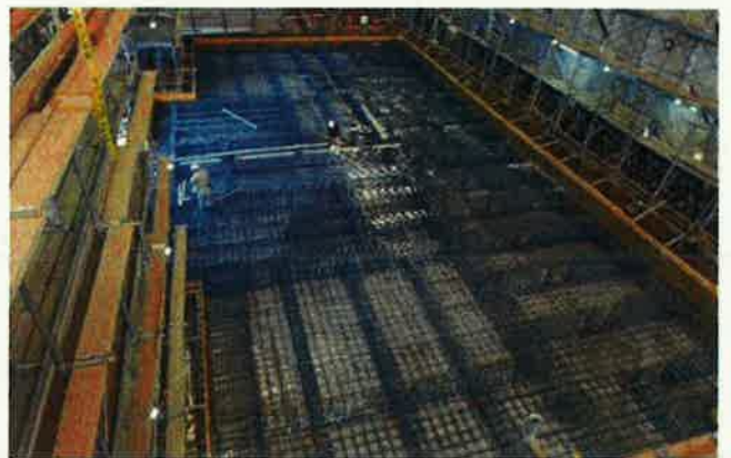
写真 17 資料館（旧本館）基礎配筋の状況
