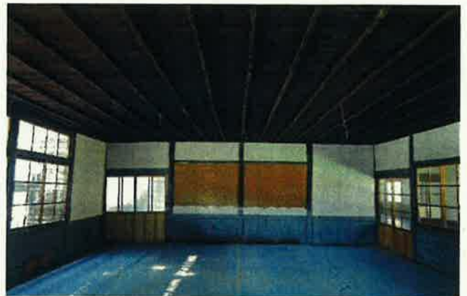
写真 7 資料館（旧本館）後補天井材解体状況（2階東教室）
