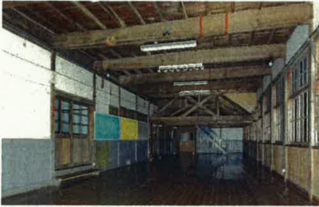
写真 14 解体前 資料館（旧本館）内観（屋内運動場）
