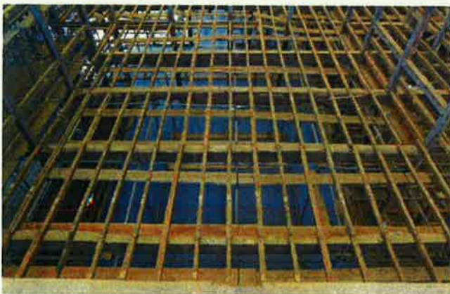
写真 10 資料館（旧本館）床組の状況（2階東教室）
