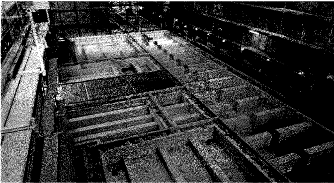
写真2 資料館(旧本館)土台の据付状況
