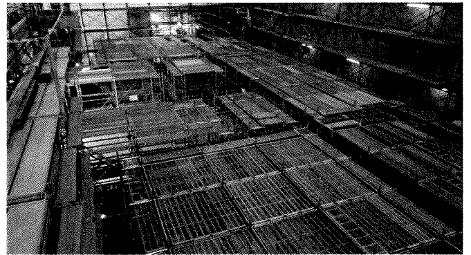
写真3 資料館(旧本館)建方の仮設足場組立状況
