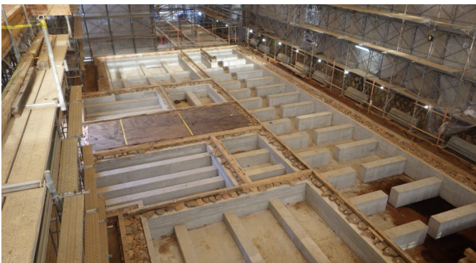
写真2 資料館(旧本館)土台の据付状況
