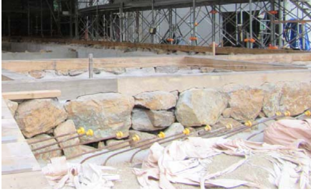
写真8 土台の据付状況
