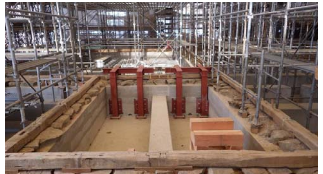
写真11 鉄骨補強材の組立状況
