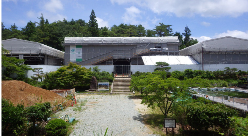
写真1 資料館(旧本館)・生涯学習施設(旧東校舎)・集会場(旧西校舎) 正面
