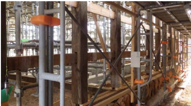
写真10 木軸組みの組立状況
