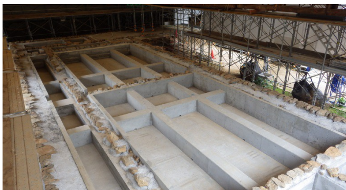
写真6 集会場・西廊下(西校舎)基礎石積み状況
