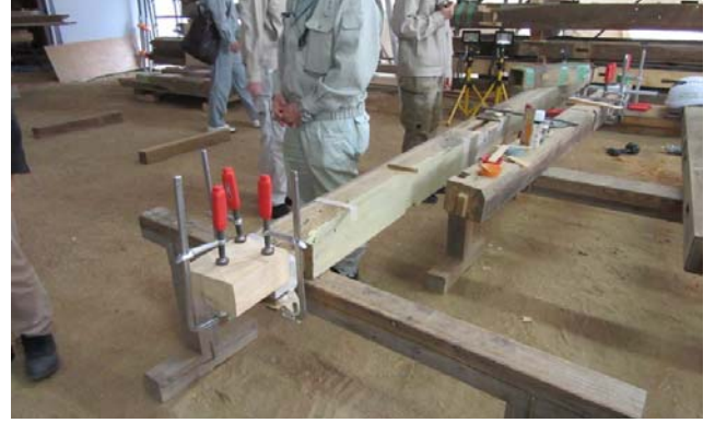
写真9 木材の加工・繕いの状況
