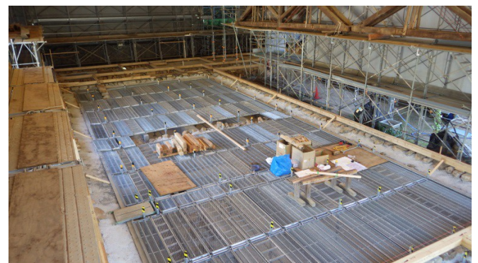
写真7 集会場・西廊下(西校舎)土台の仮据付状況
