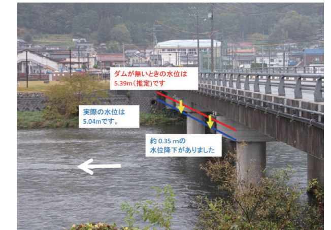
河本ダム下流水位低減効果 (川合橋水位観測所)
