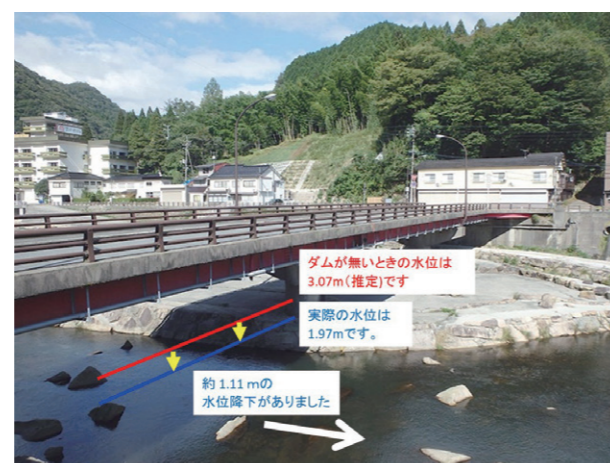
湯原ダム下流水位低減効果（湯原大橋）
