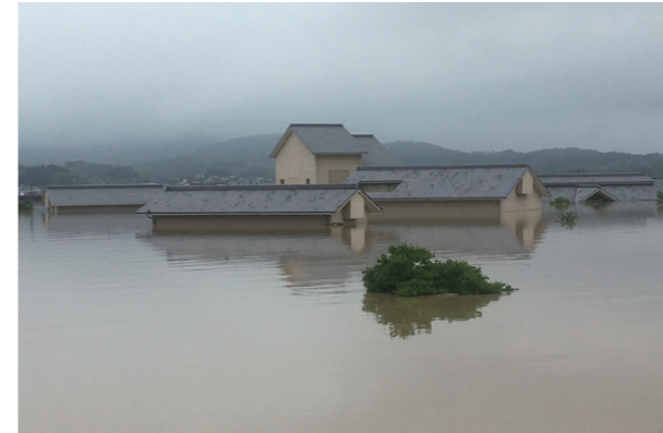
浸水した真備浄化センター
