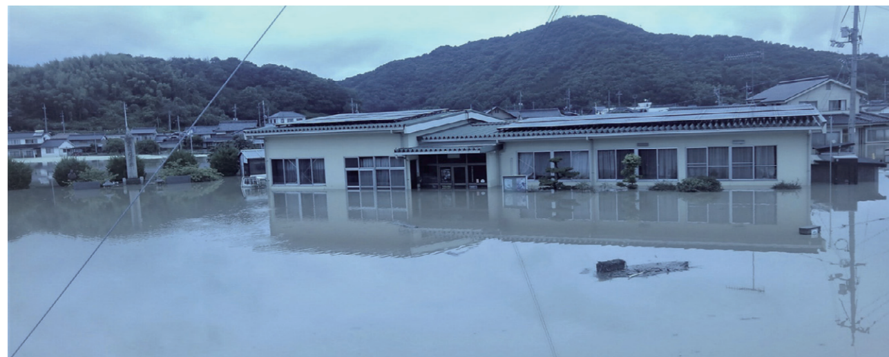
水没した公民館（矢掛町立中川公民館）
