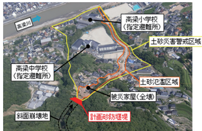
【土石流】陰地川・高梁市落合町近似
