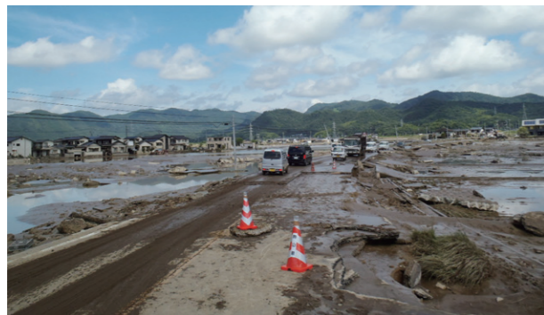
県道倉敷美袋線(倉敷市真備町服部)
