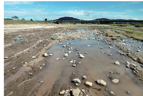
芝の大部分が流失した高梁川河川敷グラウンド
