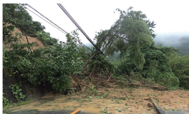
矢掛町での電柱被害
