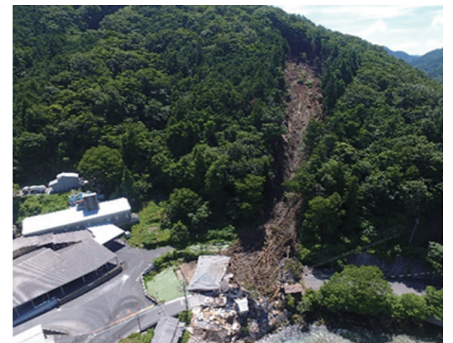
山腹の崩壊(新見市足立)
