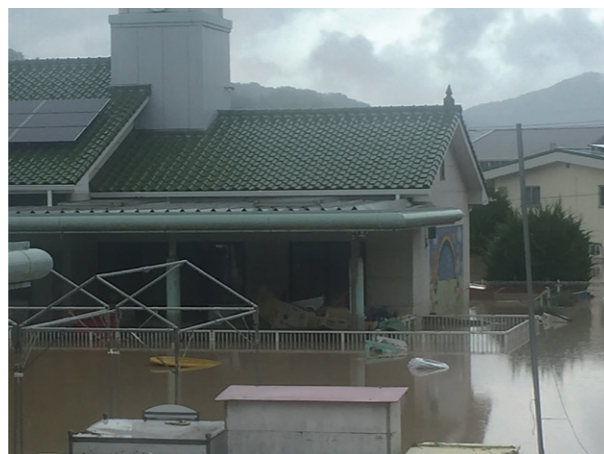
浸水した矢掛町立中川保育園
