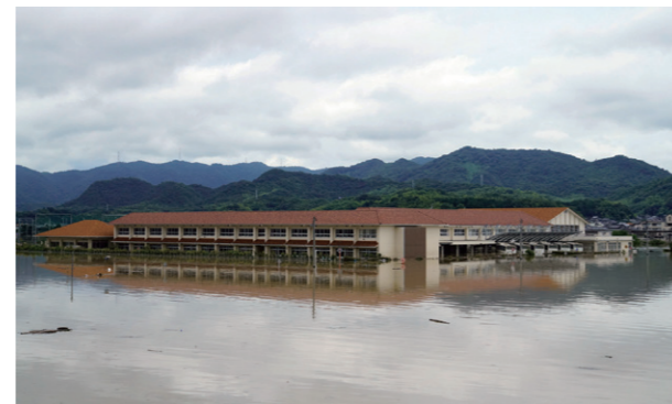
水没した校舎（県立倉敷まきび支援学校。県民等からの提供写真）
