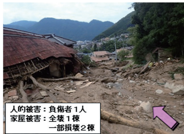
【土石流】陰地川・高梁市落合町近似
