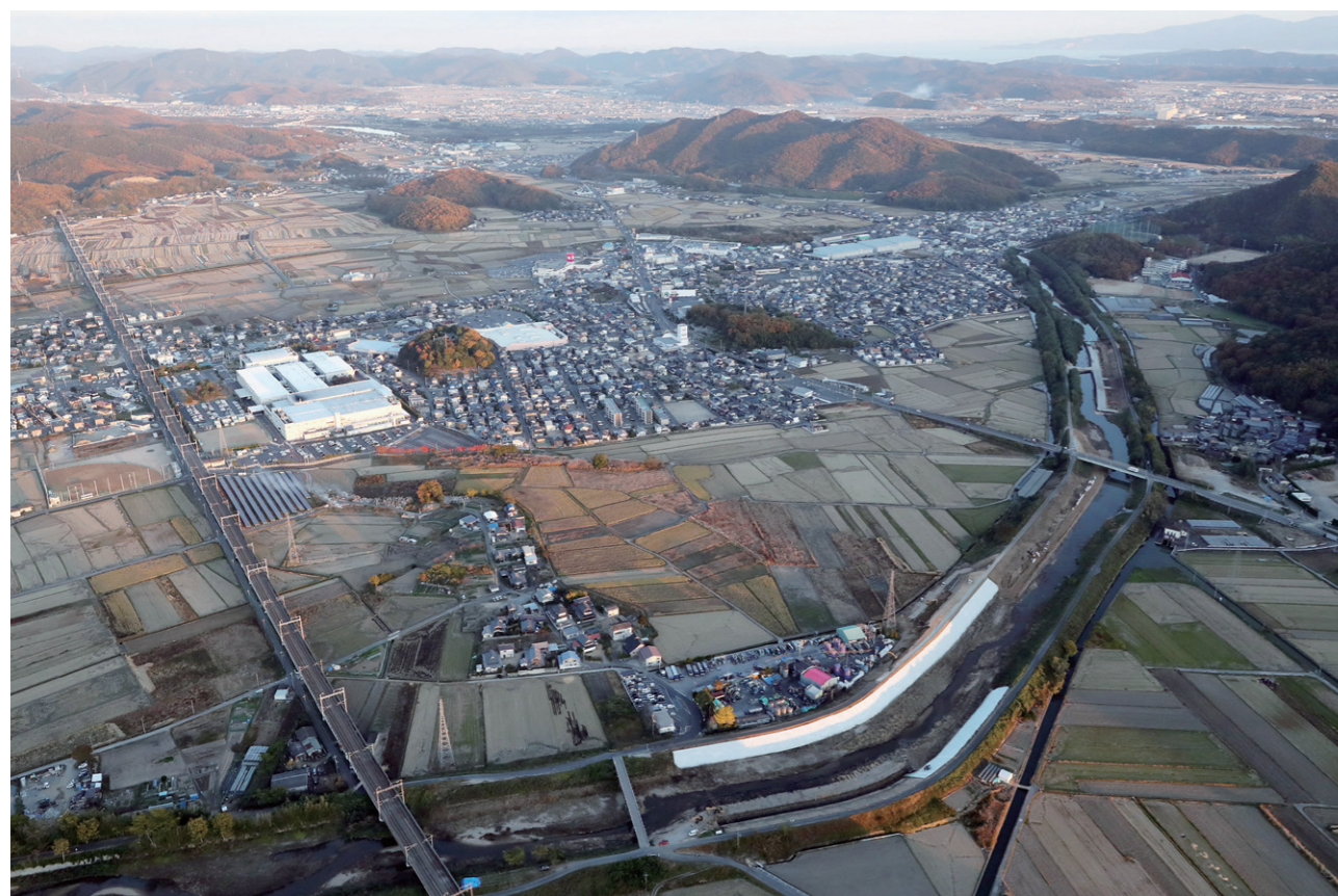
決壊箇所の改良復旧工事が完了した砂川（令和元年 11 月 21 日）
