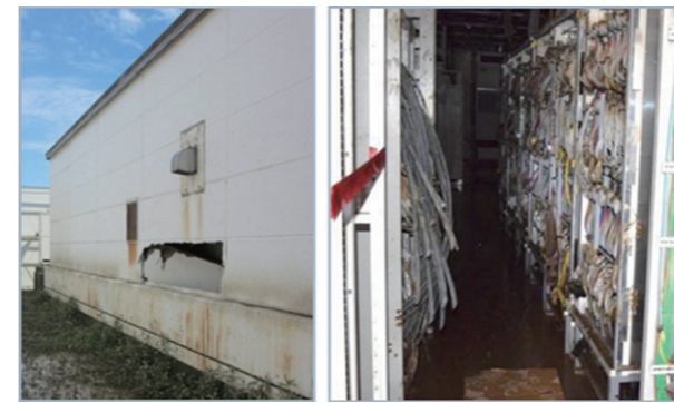
真備電話交換所の水没被害
