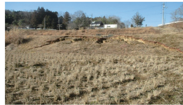
水田の畦畔崩壊(美咲町)
