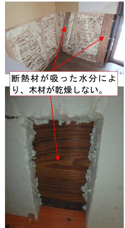
断熱材被害状況 上：吹付ウレタンフォーム 下：押出発泡ポリスチレンフォーム
