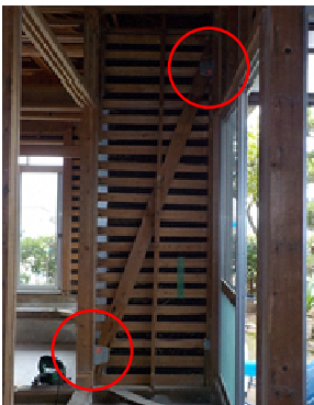
③既設筋交い 金物補強
