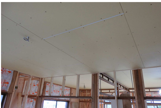
⑧天井下地
