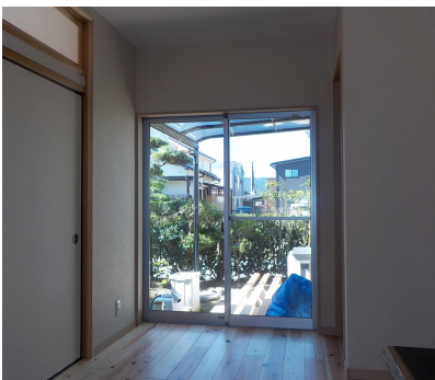
⑥サッシ復旧完了
