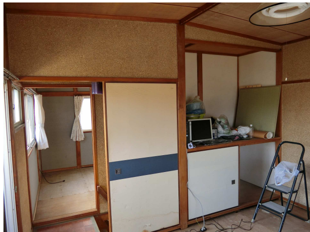
②工事前（2階）
