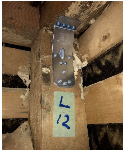
③接合部金物<柱頭・柱脚> ※N値計算により算出した金物を取付
