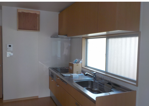
⑨完成（台所）
