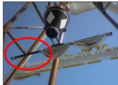
ロープ（両端2か所をリベットで固定）
