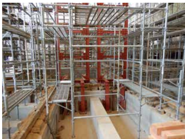
資料館 耐震補強造作
