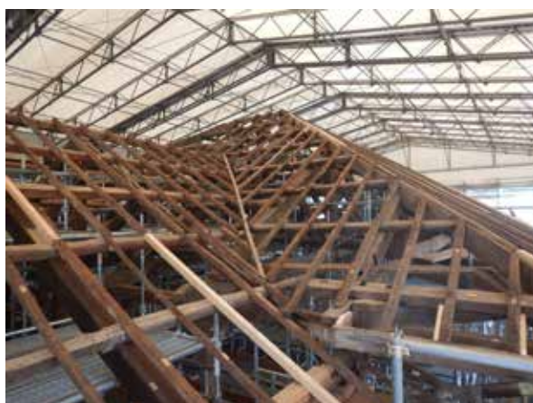
資料館 屋根組立
