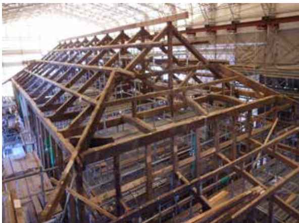
生涯学習施設 屋根組立
