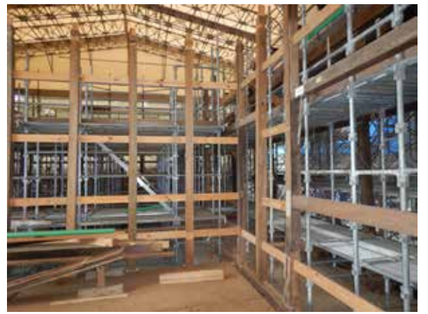
生涯学習施設 軸組組立
