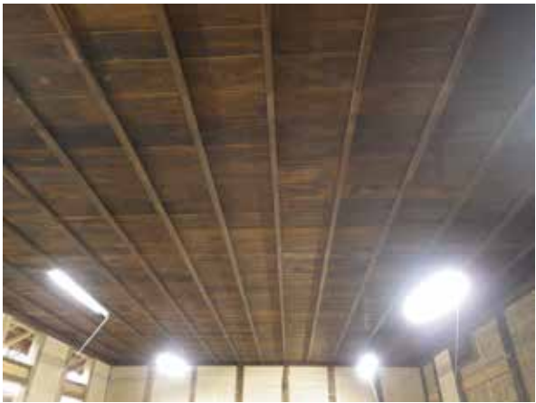
生涯学習施設 天井板張り
