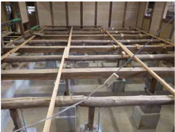
生涯学習施設 1階床下地
