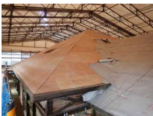
資料館 構造用合板張り
