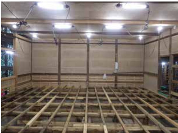
資料館 1階床下地
