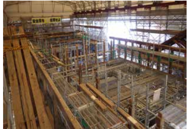
生涯学習施設 軸組組立
