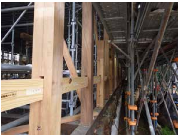
生涯学習施設 軸組組立
