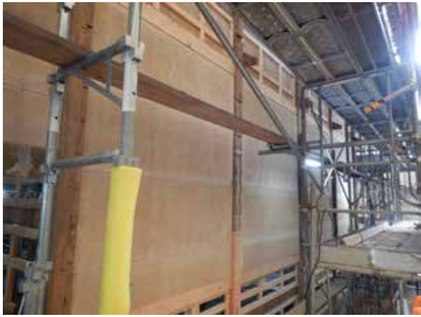
資料館 荒壁パネル設置後
