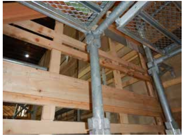
資料館 荒壁パネル設置前
