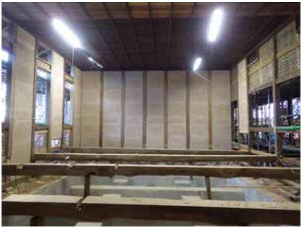
生涯学習施設 荒壁パネル設置
