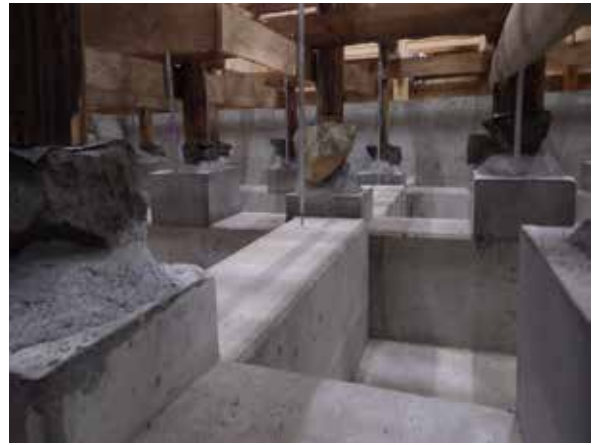
資料館 束石設置
