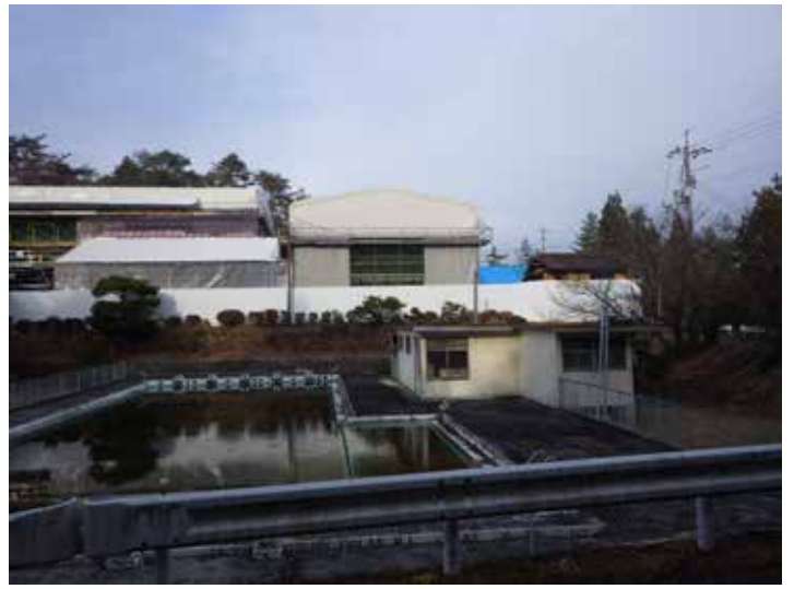
生涯学習施設 外観
