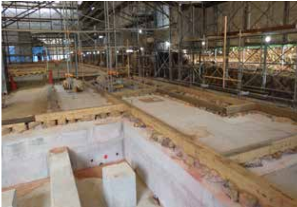
生涯学習施設 土台据付
