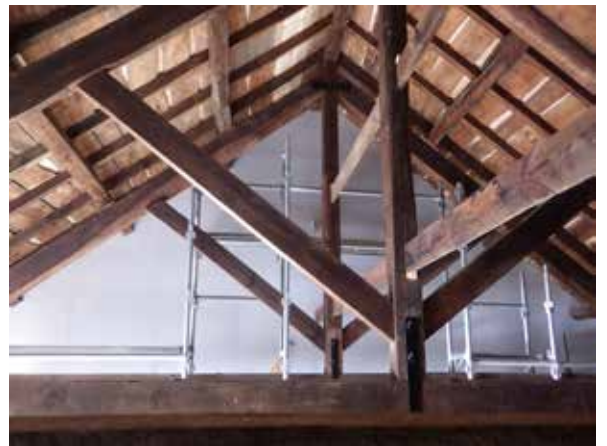
生涯学習施設 小屋裏隔壁
