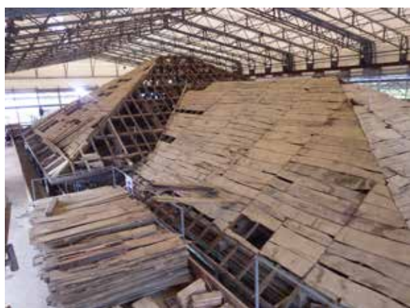
資料館 野地板張り
