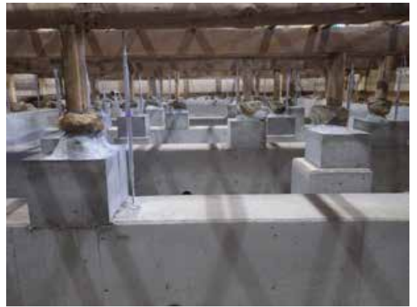
生涯学習施設 束石設置
