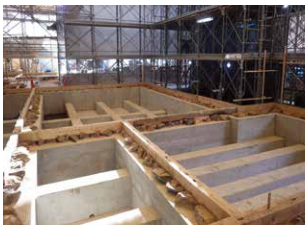
資料館 土台据付
