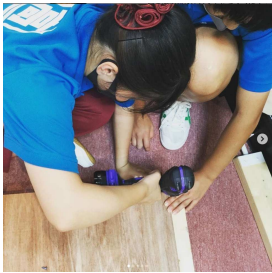
柱にベニア合板をビスでとめる作業
