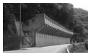
(落石防護柵の設置)
