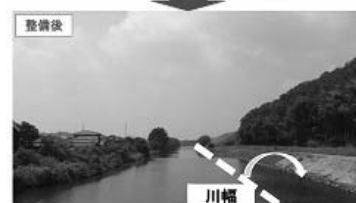
(河川改修による川幅の拡張)
