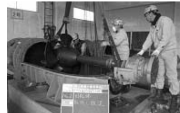
(排水機の整備・補修)
