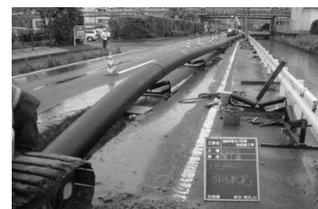
(工業用水配水管の更新・高密度ポリエチレン管の布設例)
