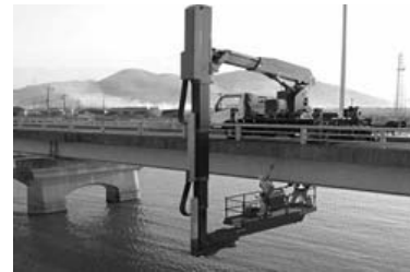
(農道橋の点検)
