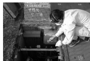
(農業集落排水施設の点検)
