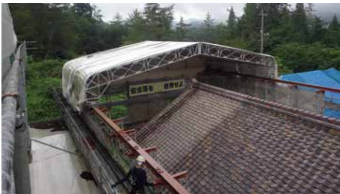
東校舎 素屋根解体
