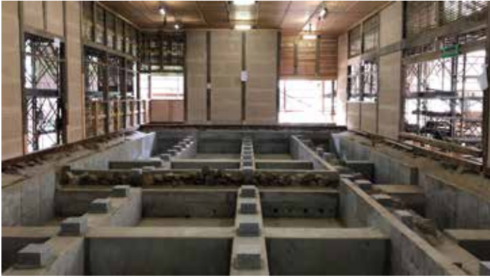
西校舎 集会室 東石据付
