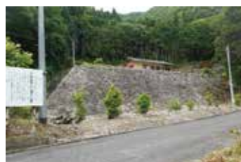
⑱ 井川発電所跡
