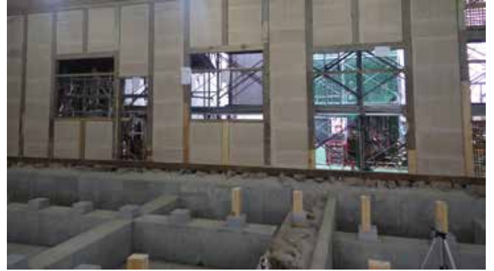
西校舎 集会室 東石据付
