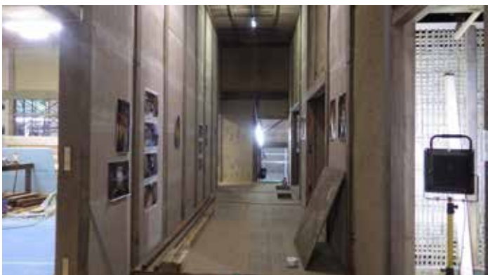
西校舎 北側廊下
