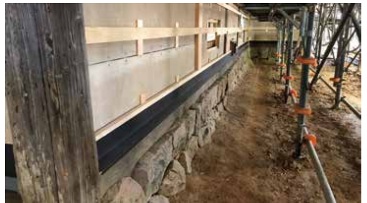
本館 1階 南西側外壁下地
