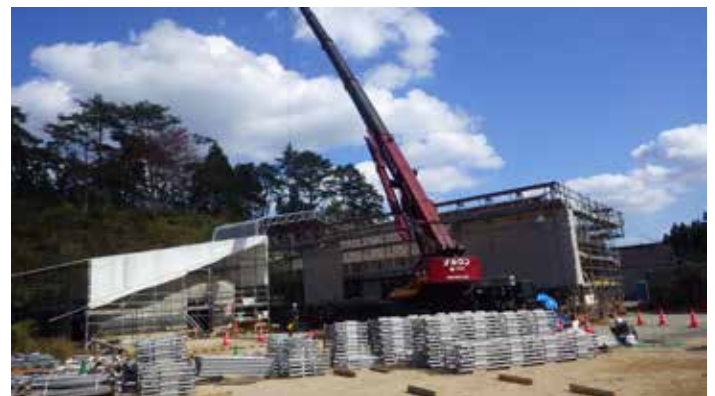
西校舎 素屋根解体
