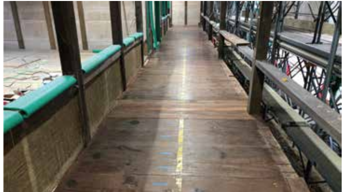
東校舎 廊下（西側）
