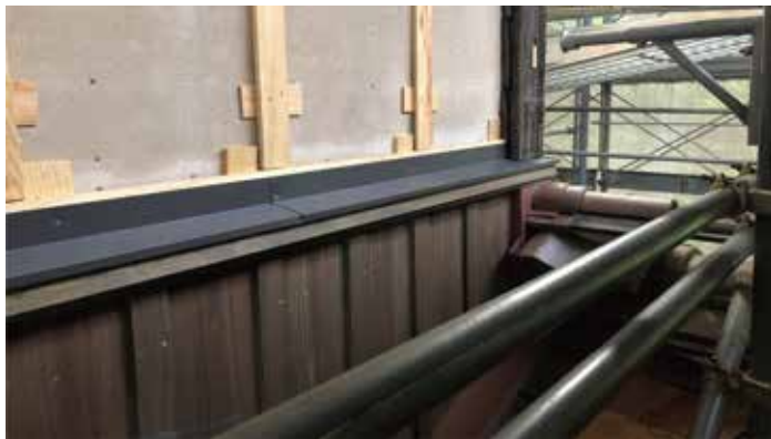
本館 2階 北東側外壁下地等
