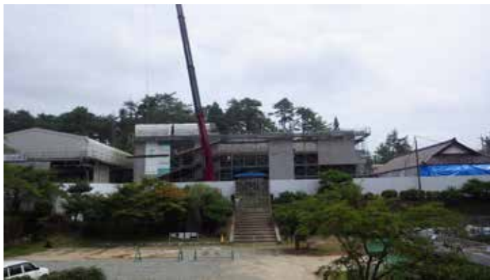
本館 素屋根解体
