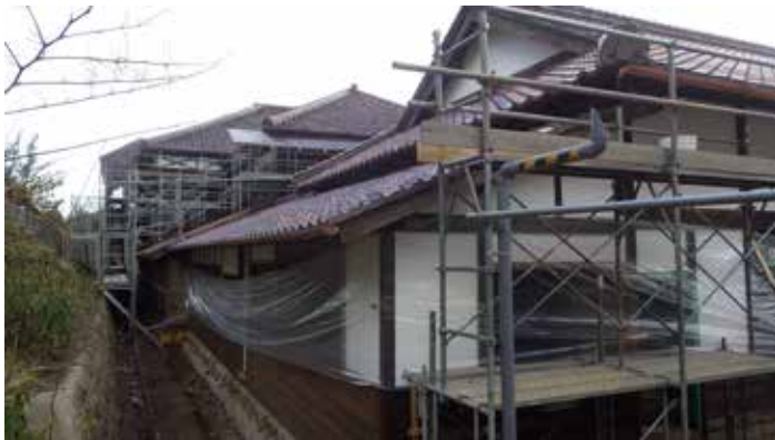
西校舎・西廊下 北側外観
