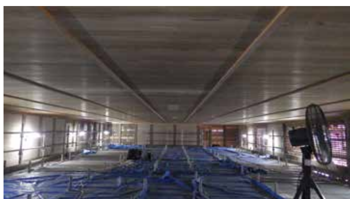
西校舎 集会室 天井
