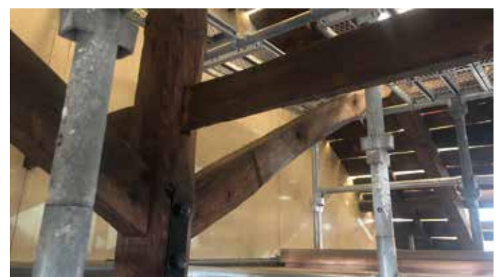
西校舎 小屋裏隔壁
