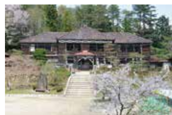
⑮ 旧吹屋小学校校舎
