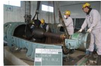
(排水機場の整備・補修)
