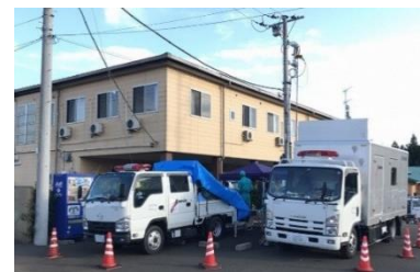
(避難所へ給電する電源車)
