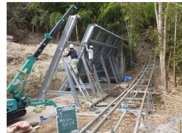
(治山施設の補修・機能強化)
