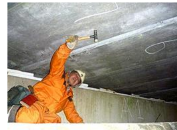
(林道橋の調査・点検)
