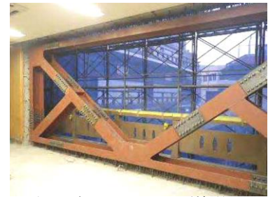
(鉄骨ブレースによる耐震補強)
