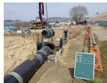
(工業用水道管の耐震管への更新・鋼管の布設)
