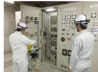
（空港内発電機の点検）
