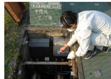
（農業集落排水施設の点検）
