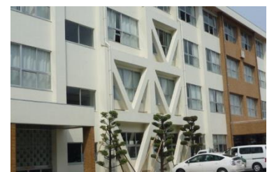
(県立学校耐震補強工事)
