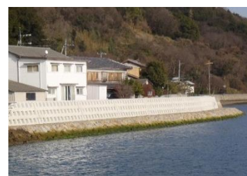
(海岸保全施設の整備)
