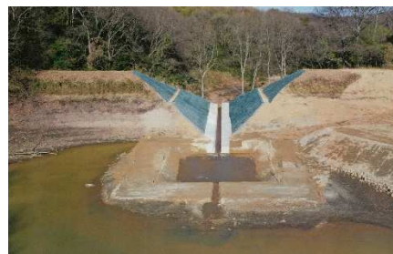
防災重点農業用ため池の廃止工事
