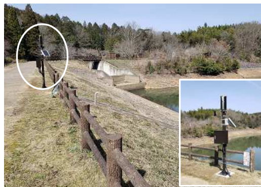
水位計の設置
