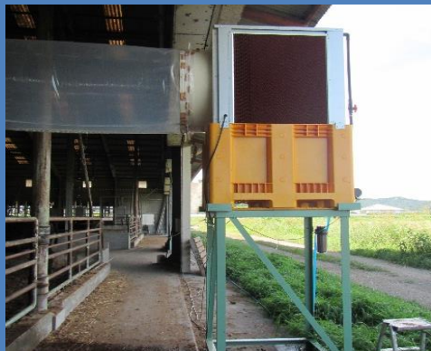
ダクトの設置
