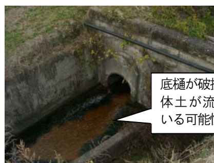
写真11：底樋出口（堤体下流）
