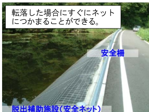
写真15：安全ネットの設置
