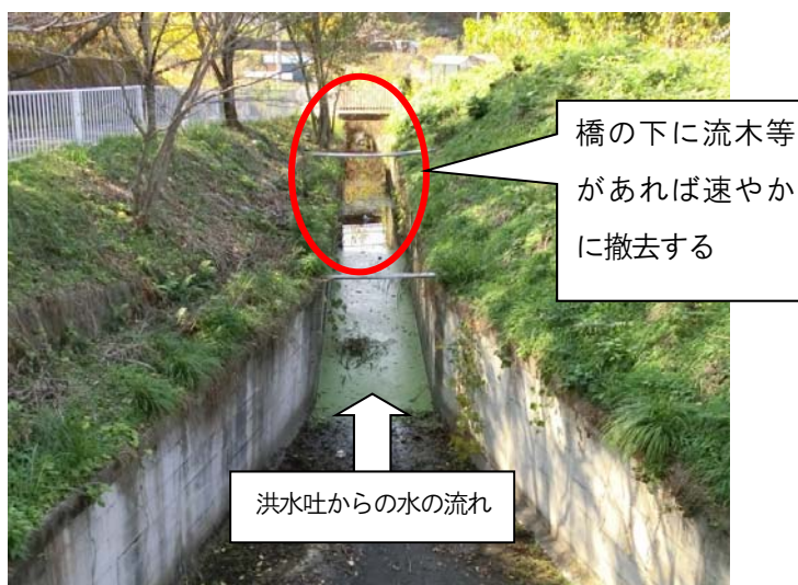
写真8：洪水吐下流水路の例
