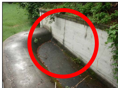
写真9：洪水吐流入部
