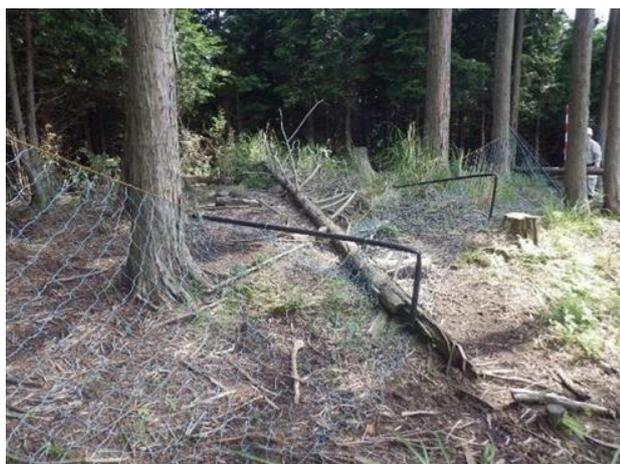
参考資料-3 倒木による支柱の折損
