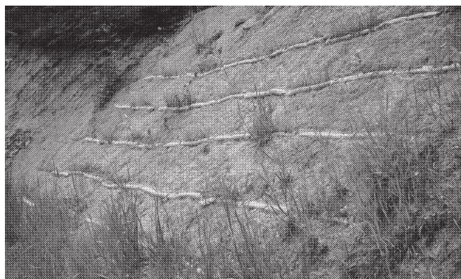
写真-8 法面5の棒状植生マットの設置状況
