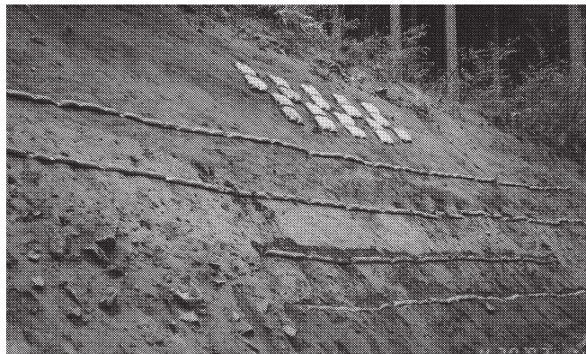
写真-7 法面6の板状Oマットの設置状況
