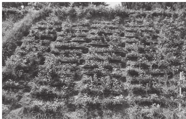
写真-19 棒状Aマットの植被状況
