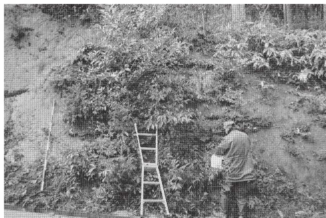
写真-22 法面 7 の棒状Qマットの植被状況
