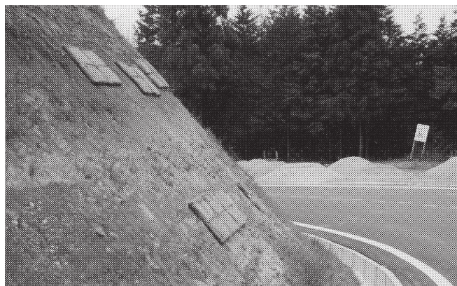
写真-3 法面1の板状植生マットの設置状況
