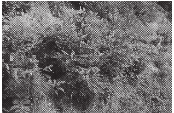
写真-16 板状Nマットの植被状況
