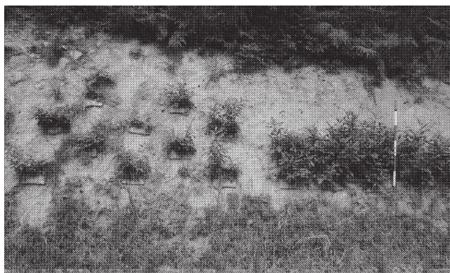
写真-6 法面5の板状植生マットの設置状況
