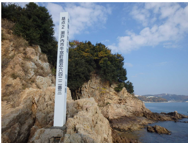
修復した基点の標柱
