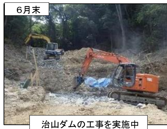
治山ダムの復旧状況(倉敷市広江)
