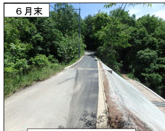
林道施設の復旧状況(新見市新見)
