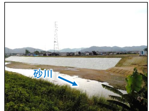
砂川（岡山市東区沼）の復旧状況
