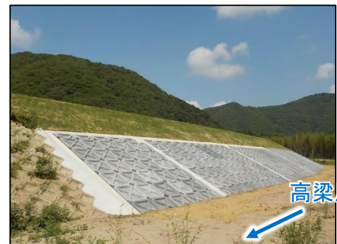
高梁川（総社市下倉）の復旧状況
