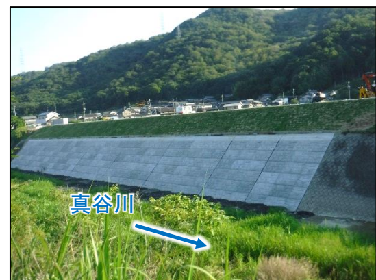
真谷川（倉敷市真備町服部）の復旧状況
