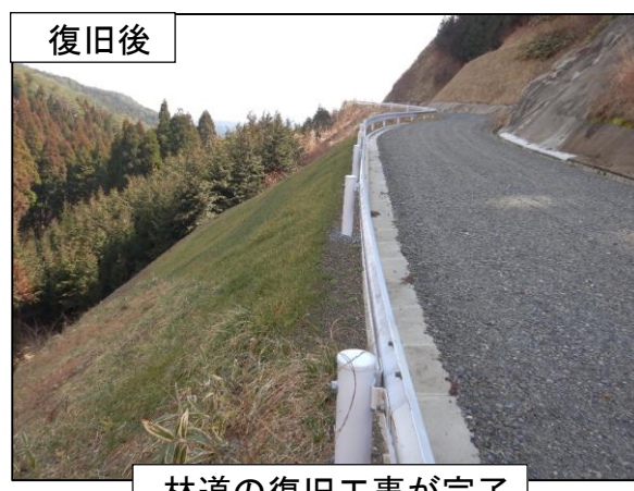
林道施設の復旧状況(真庭市清谷)
