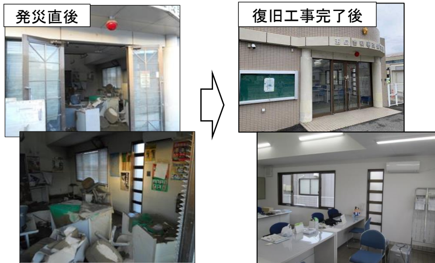
玉島警察署真備交番の復旧状況(倉敷市真備町)
