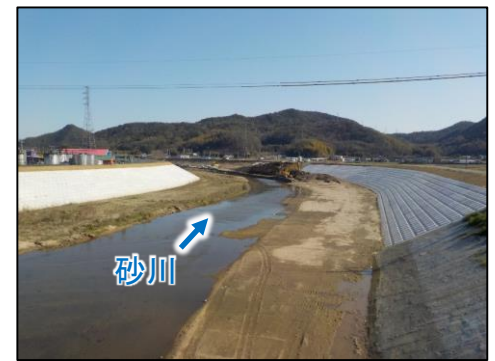
砂川（岡山市東区沼）の復旧状況
