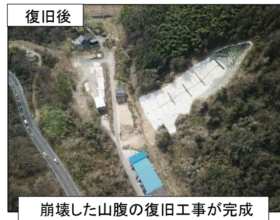
山腹崩壊の復旧状況(矢掛町横谷)
