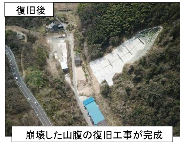
山腹崩壊の復旧状況（矢掛町横谷）
