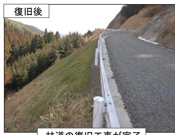
林道施設の復旧状況（真庭市清谷）
