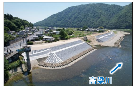
高梁川（総社市日羽）の復旧状況
