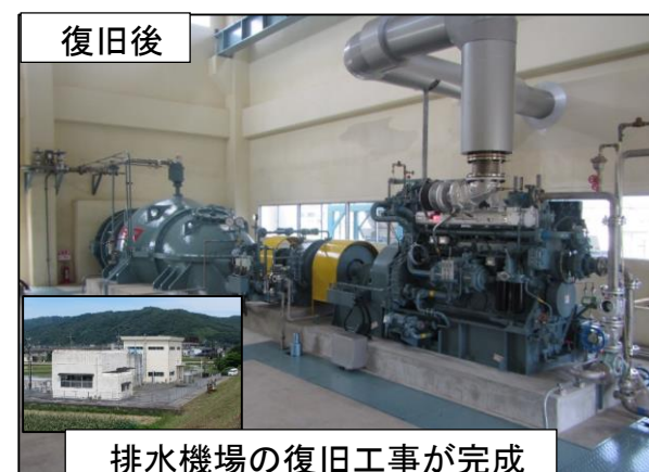
排水機場の復旧状況 (倉敷市真備町)
