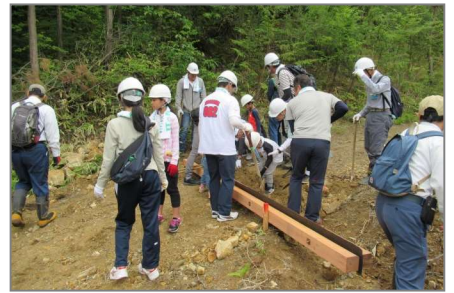
作業道の修繕
