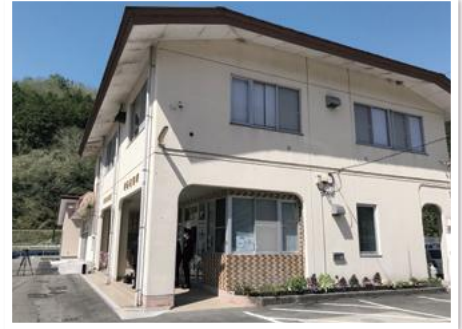
改修した施設(新見市上熊谷地区)
