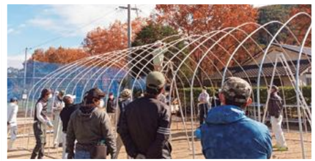
ビニールハウスの組み立て研修
