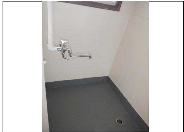
浴槽設置場所
