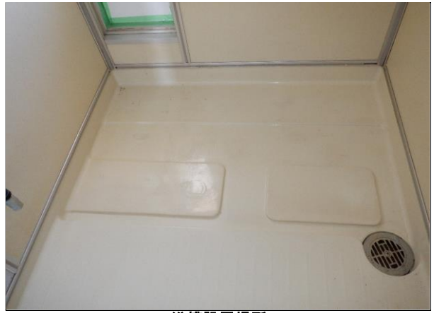
浴槽設置場所
