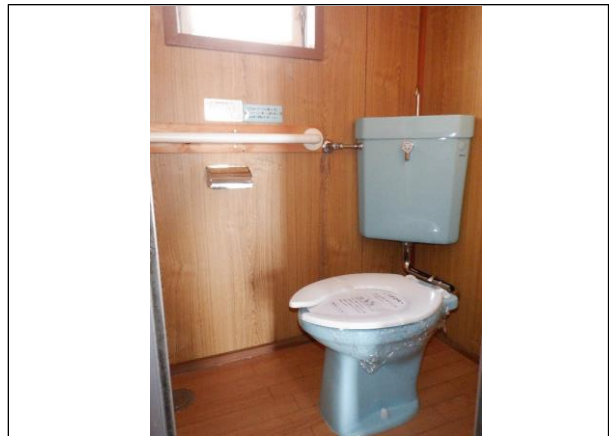
トイレ(手すり有)
